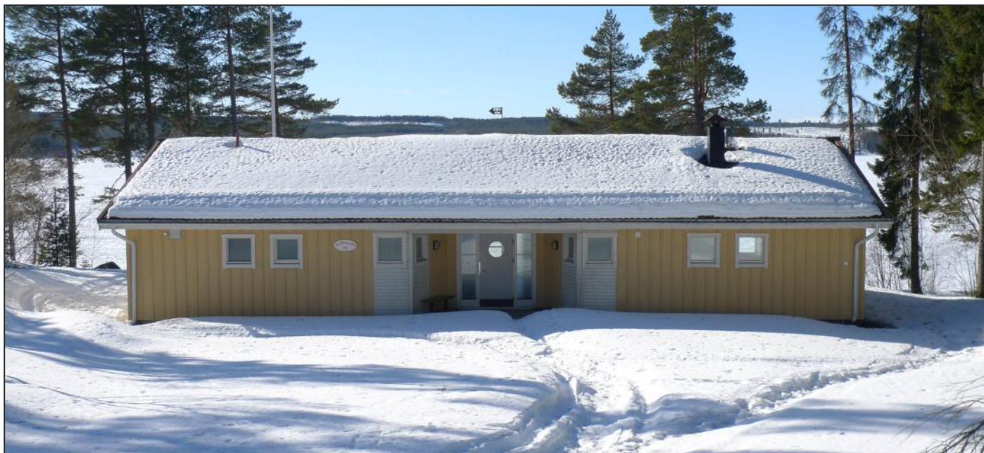
“Ås-Hov 1:173 den sk Sjövillan”, fd Bagarstuga och förskola. Lugnviksvägen 175, 831 52 Östersund
